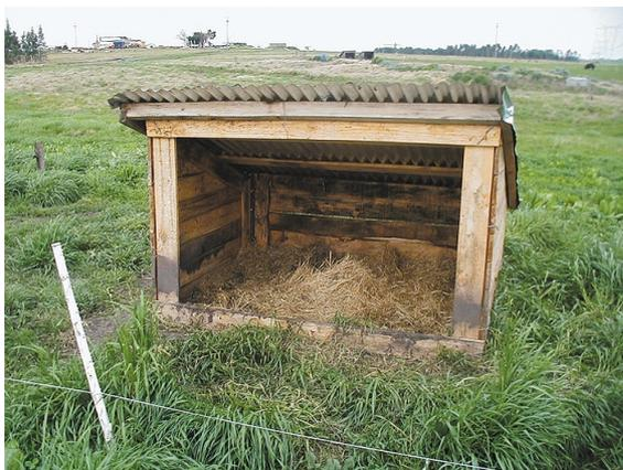
La instalación está construida con 5 módulos (cuatro paredes y techo) que se arman y desarman con facilidad, permitiendo su traslado en el campo. Las paredes están construidas con tablas de encofrado y el techo puede utilizarse paja (quincho), chapa o cartón asfáltico.
